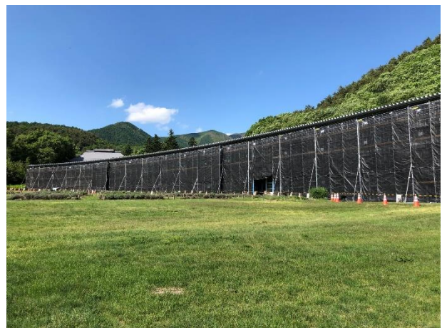
【中庭からの外観】
